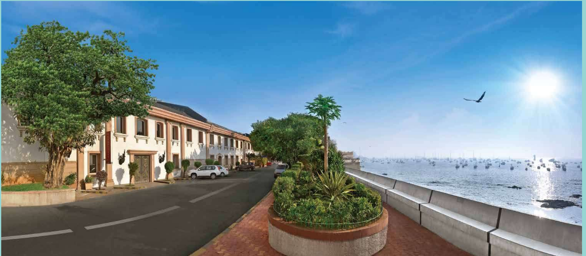
ACTUAL IMAGE OF SP CENTRE, COLABA-MUMBAI
